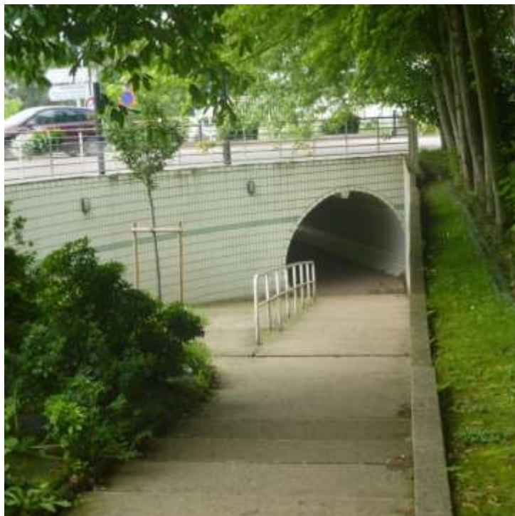
Le passage piéton sous l'avenue Pierre Brossolette
